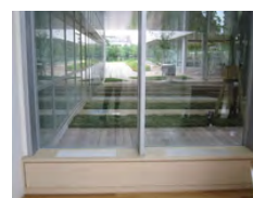
室内のクールチューブ(噴出し)
