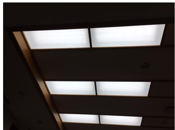
本部棟 4 階ホール照明
